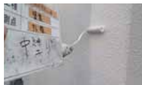
外壁塗装中塗り
