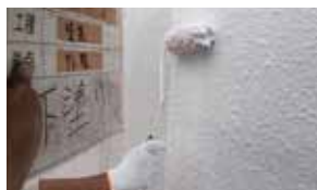
外壁塗装下塗り
