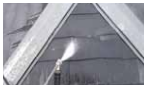
屋根高圧洗浄
