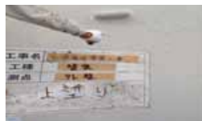
外壁塗装上塗り
